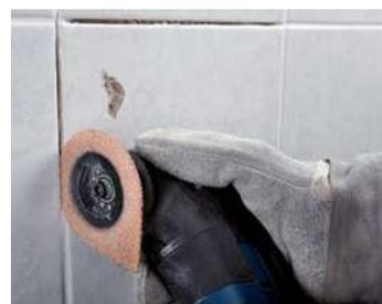
**Ideal para eliminar grout y mortero de juntas de paredes y suelos, incluso en las esquinas más remotas.**
