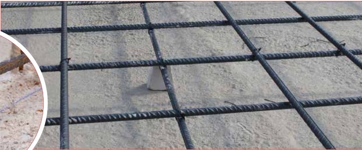
Separador cubito Concrete cube spacer Cale béton bloc
