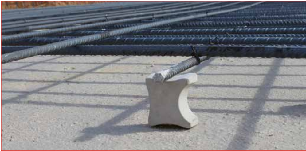
Separador trivalente Concrete trivalent spacer Cale béton trivalente
