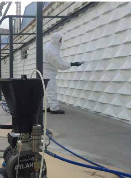
Bomba eléctrica de membrana. Aplicación de lacas, fondos, imprimaciones, esmaltes y barnices. En general, productos de media viscosidad.
